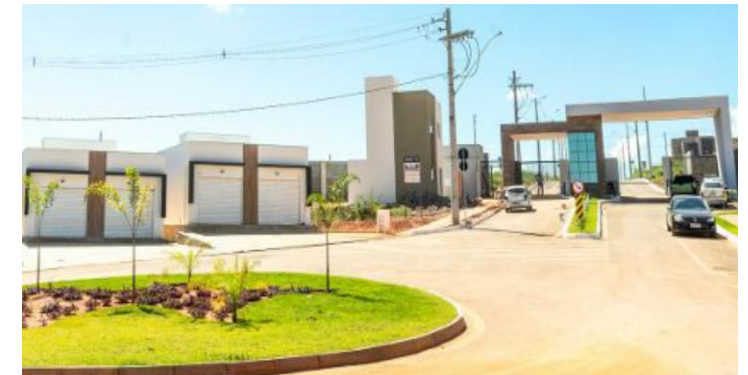
Entrada do empreendimento
